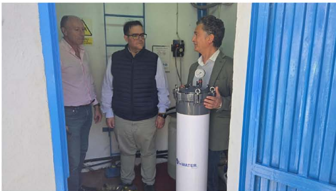
Robles, Caballero y Jurado junto al nuevo filtro de turbidez de agua
