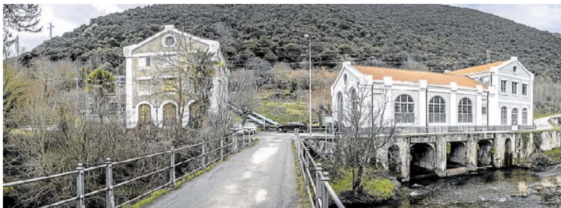
Central hidroeléctrica en el río Najerilla, en la localidad de Anguiano. JUSTO RODRÍGUEZ
